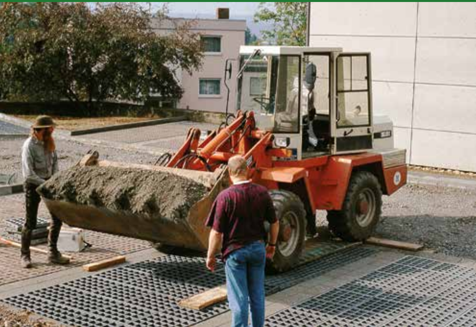
Fugenverfüllung nach dem Verlegen auf 2-3 cm Ausgleichsschicht
