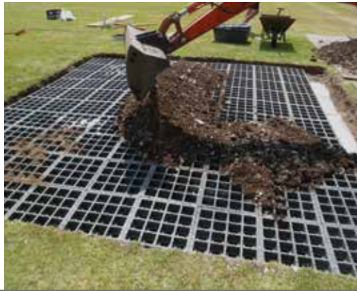
2. TTE®-Aufbau mit Rasentragschicht-Textilgemisch
