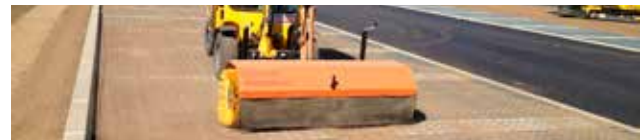
Herstellen der Unterfüllung mit Hilfe einer Kehmaschine
