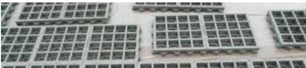
Verlegen der TTE ® -Elemente auf Feinnetz (Verlegehilfe)
