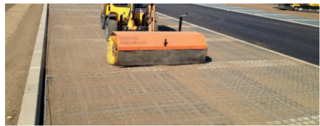
Herstellen der Unterfüllung mit Hilfe einer Kehmaschine
