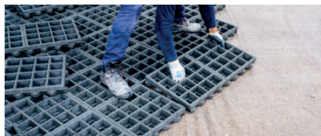
Verlegen der TTE® Elemente auf Feinnetz (Verlegehilfe)
