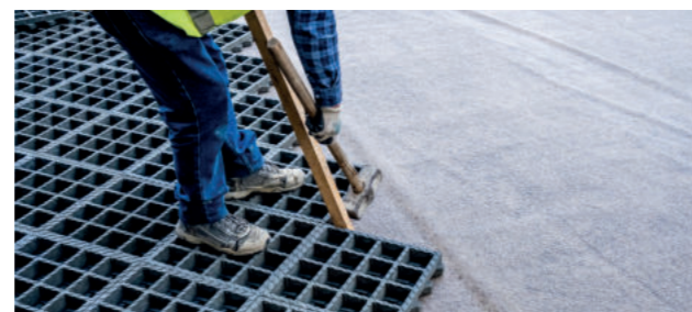
Auf enge Verlegung und regelmäßiges Nachklopfen achten, um eine spätere Fugenbildung zu verhindern.
