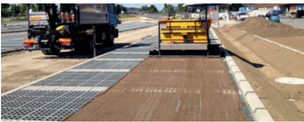
Aufbringen der Verfüllung mit einem Fertiger
