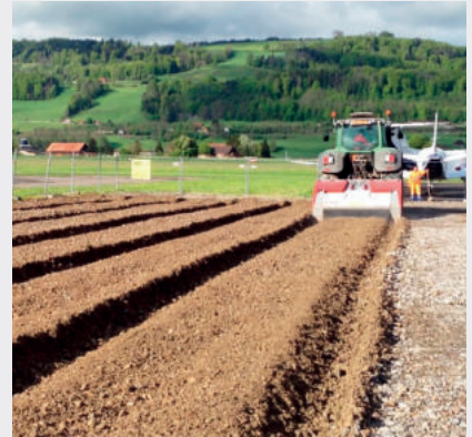
Einfräsen des Schottergemischs in den Oberboden
