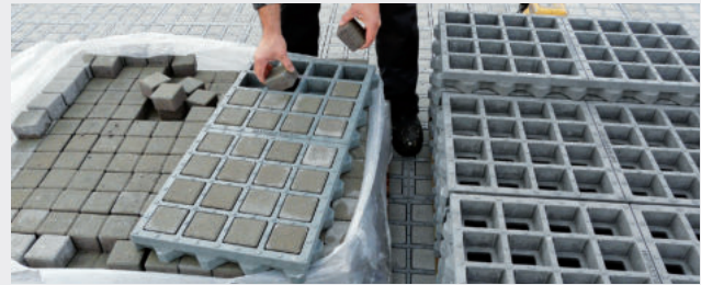
Einsetzen der Pflastersteine in das TTE® Element
