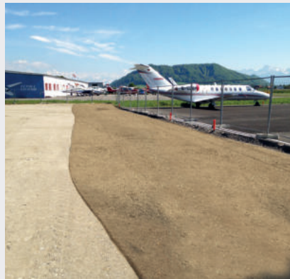
Ausbringen und Ebnen der Bettung (Splitt-Oberboden- Gemisch)
