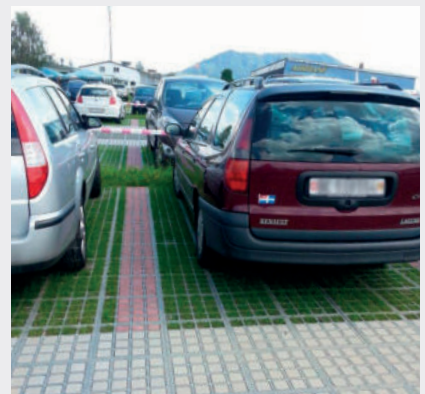
Ansatz und Fertigstellung
