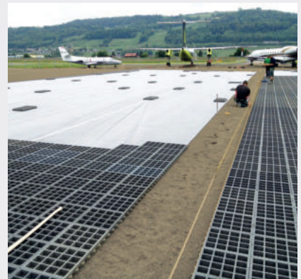
Verlegen der TTE® Elemente auf Feinnetz (Verlegehilfe / Trenngewebe)
