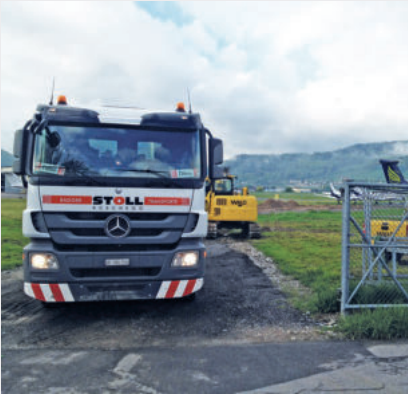
Abtrag der Grasnarbe; Anlieferung von Schottertragschichtmaterial
