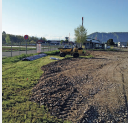
Aufbringen und Verteilen des Schottergemischs direkt auf bestehendem Oberboden
