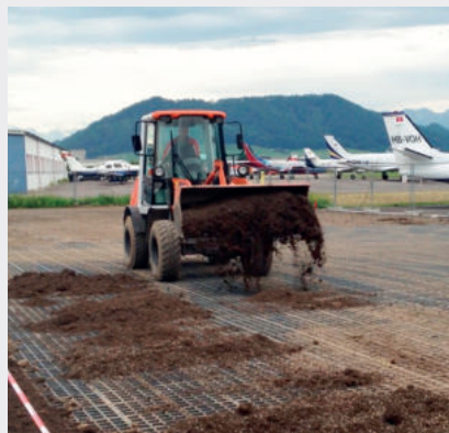
Einbringen des Substrates (Oberboden-Sand-Gemisch) als Kammerverschüttung
