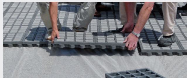
Verlegen der verfüllten TTE® Elemente zu zweit
