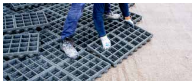
Verlegen der TTE® Elemente auf Feinnetz (Verlegehilfe)
