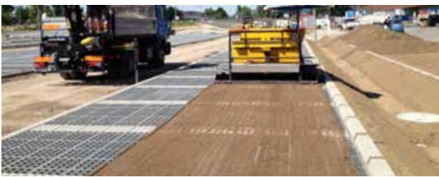
Aufbringen der Verfüllung mit einem Fertiger
