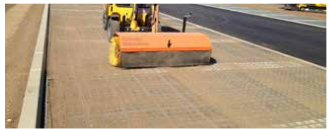
Herstellen der Unterfüllung mit Hilfe einer Kehmaschine
