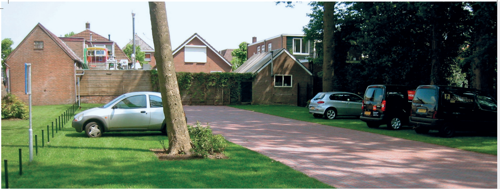
Wurzelbereiche von alten, wertvollen Baumbeständen können einfach überbaut und geschützt werden.
