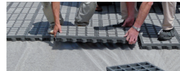
TTE® Element verlegen, indem die Verzahnung ineinandergeschoben wird.
