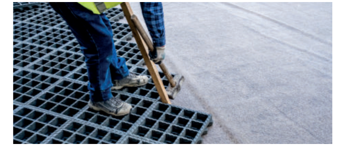
Auf enge Verlegung und regelmäßiges Nachklopfen achten, um eine spätere Fugenbildung zu verhindern.
