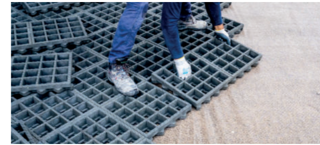
TTE® Element verlegen, indem die Verzahnung ineinandergeschoben wird.
