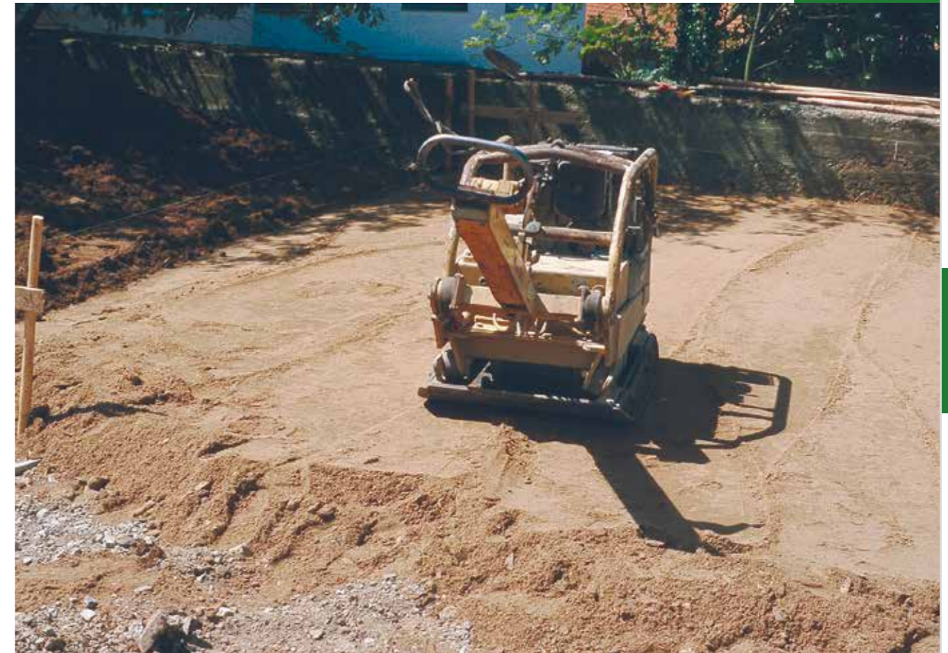
Einbau eines nicht bindigen Untergrundmaterials auf der Versuchsfläche.
