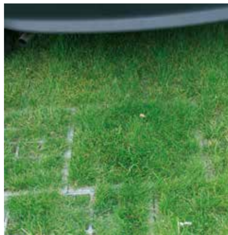
Flächendeckung der Vegetation auf nicht bindigem Baugrund im Herbst 2001
