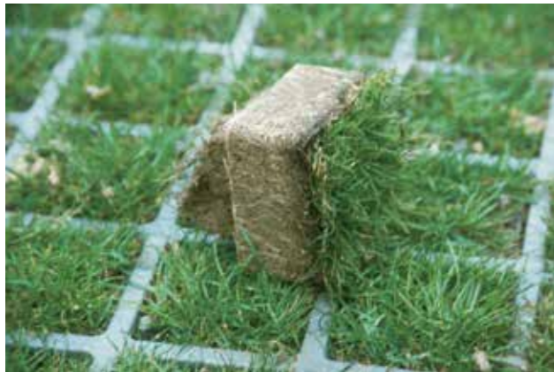
Kammerfüllung und Baugrund werden zum Wurzelraum
