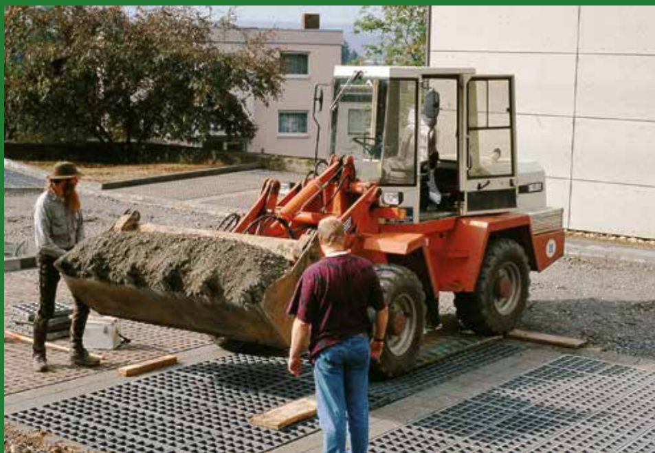
Fugenverfüllung nach dem Verlegen auf 2-3 cm Ausgleichsschicht
