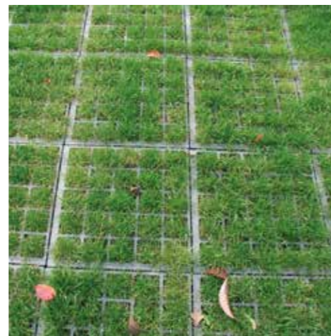
TTE® Rasengitter im Fugenversatz im Sommer 2002
